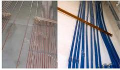
**Трубы из хлорированного поливинилхлорида** обладают самым низким коэффициентом линейного расширения среди термопластов. Они могут использоваться в системах водоснабжения и отопления жилых здания, однако следует помнить что утвержденного регламента и свода правил по трубам из хлорированного поливинилхлорида не предусмотрен, а существующий ГОСТ относит такие трубы к третьему классу. То есть температура теплоносителя не должна превышать 40 оС.
